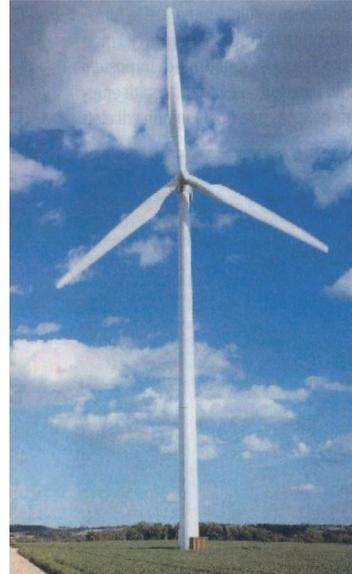
**Fig. 9** - Aerogeneratore ad asse orizzontale
