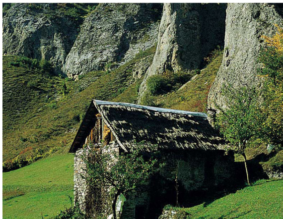
Nella borgata di Tetti Bártola (1054 m), una abitazione è stata restaurata, ricostruendo in particolare l'originaria copertura in paglia di segale
