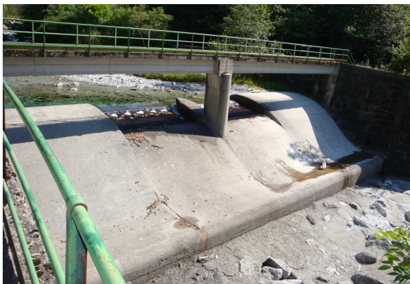
Fig. 6. Val di Mello (SO): derivazione idrica totale delle acque di magra.
