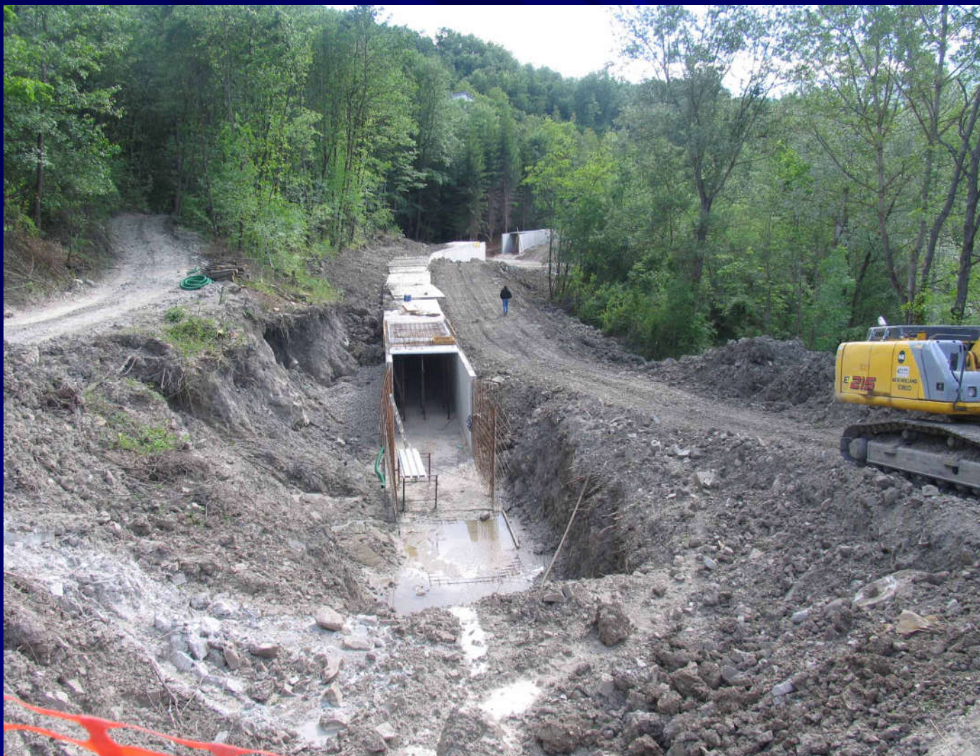
Montecreto-Pian della Valle: Conduittura dell'impianto idroelettrico sullo Scoltenna (fase di costruzione 21 maggio 2006)
