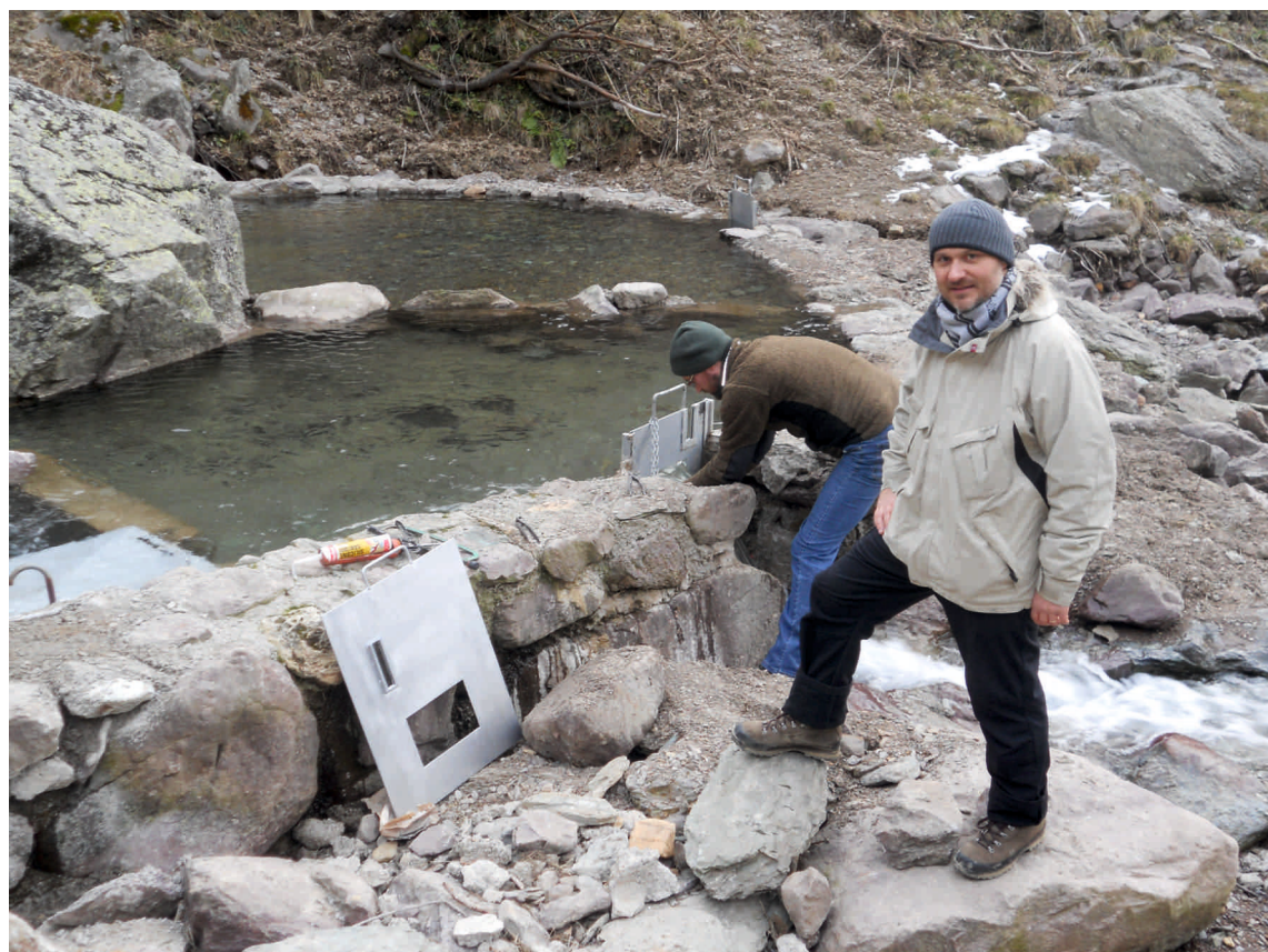
Il grande bacino di carico dell'opera di presa costruito con le pietre locali
