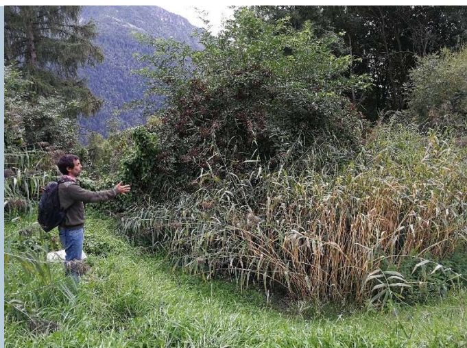
Impianto di fitodepurazione alla Casa del Parco Adamello a Cervo
