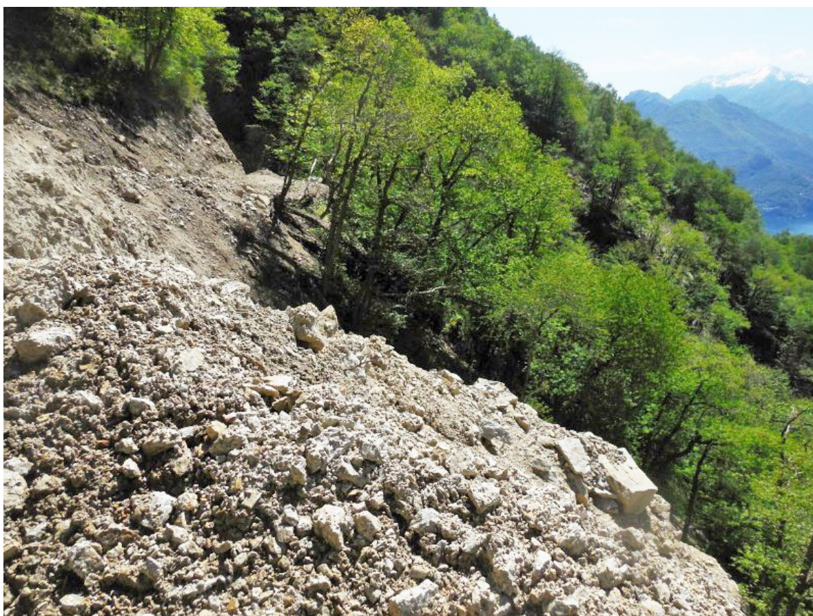
Immagine della strada in costruzione
