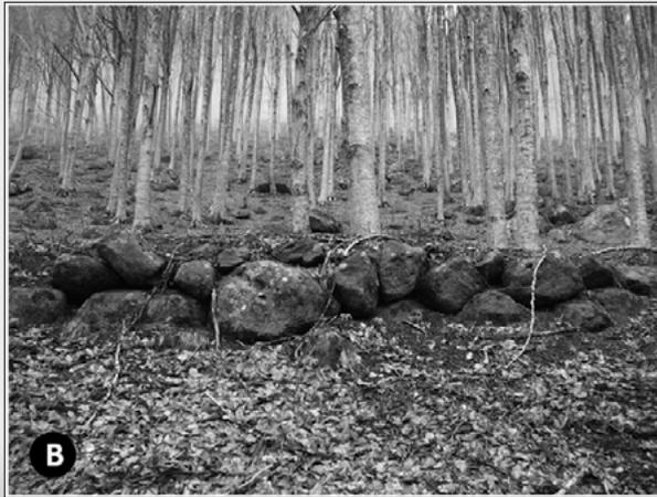
B) Vecchio muro realizzato con pietre vulcaniche per sostenere la piattaforma nelle faggete sulle ripide pendici del monte Amiata
