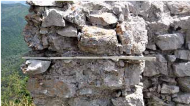
Fig. 78 - Monte Bastiglia. Particolare delle mura della cappella (larghezza cm 90 ca.). Si può notare la scarsa connessione tra le pietre, compensata dall'abbondante utilizzo di malta, ed anche la ridotta dimensione del diatono in basso a sinistra, che non supera la metà dello spessore del muro (foto Alfredo Nicastrì)
