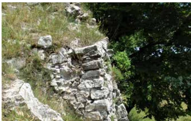
Fig. 85 – Monte Bastiglia. Versante Sud, muro di contenimento del terrazzamento. Particolare della tecnica costruttiva (foto Alfredo Nicastri)
