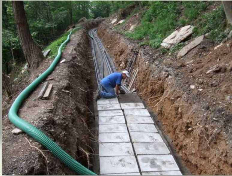
LAVORI DI INTERRAMENTO CAVI LAAX (SVIZZERA)
