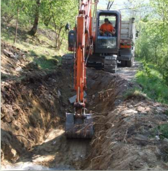
CAVIDOTTO INTERRATO A MALONNO (BS)
